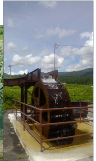
エネルギーの地産地消をめざして導入された上掛け水車で発電した電気を使い、「農産物加工所」が再稼働（平野さん提供）
