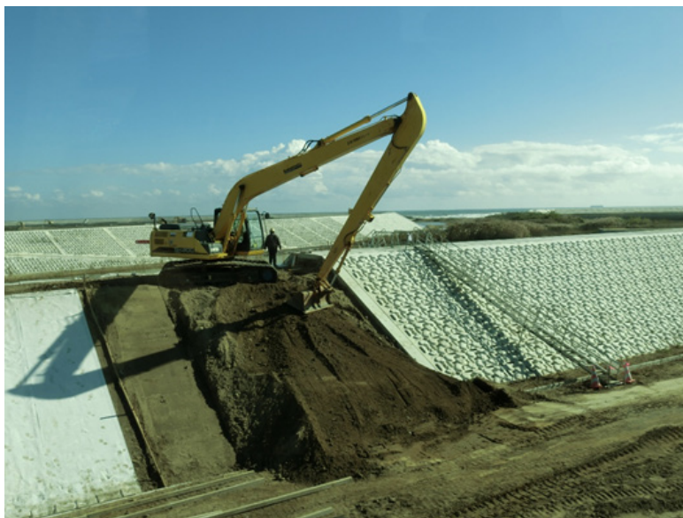
福島県復興祈念公園の工事現場そばにある数キロにわたる高さ 8 mの防波堤 (双葉町)
